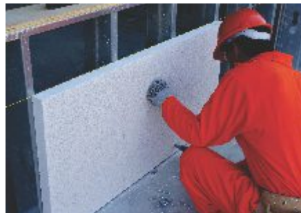
Fig. 10 Atornillado en postes centrales.
