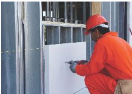
Fig. 9 Instalación de primera pieza.
