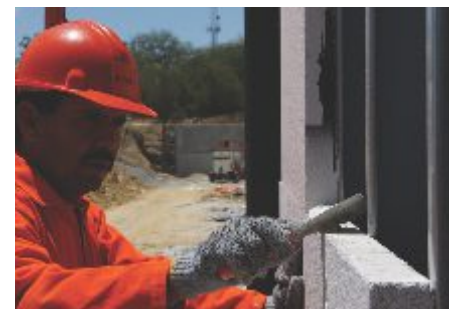
Fig. 12 Adhesivo entre paneles.
