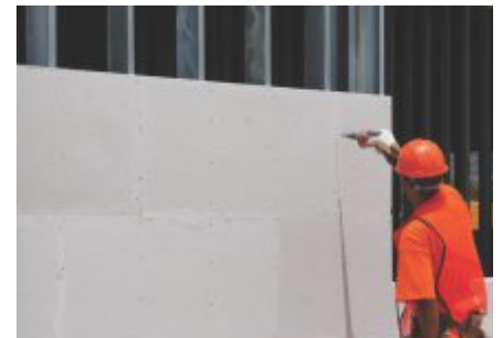
Fig. 13 Instalación de hiladas superiores.
