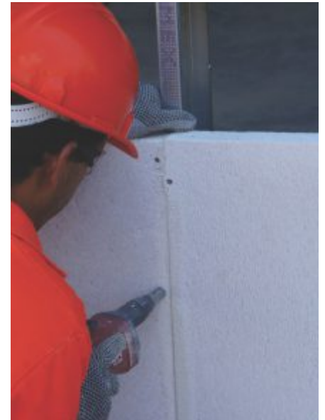
Fig. 11 Colocación de tornillos en unión.
