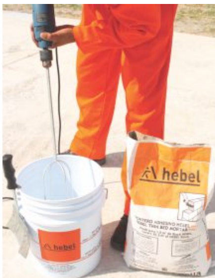
Fig. 7 Preparación de Adhesivo Hebel®.
