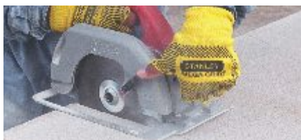
Fig. 14 Corte de Hebel® Power Panel.
