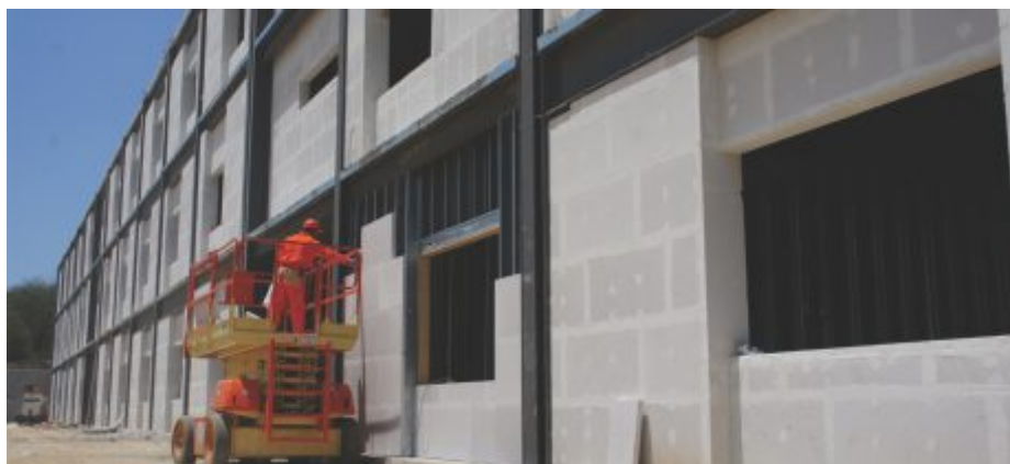
Fig. 18 Tablero de Hebel® Power Panel instalado.
